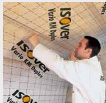
Fig. 4 Breng een lucht/dampscherm aan, zoals ISOVER vario KM duplex.
