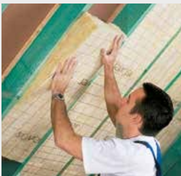
Fig. 3 Klem de isolatie tussen de kepers. Coincez l'isolation entre les chevrons.
